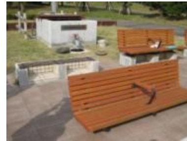
かまどベンチ(ベンチを取り外してかまどとして使用)
